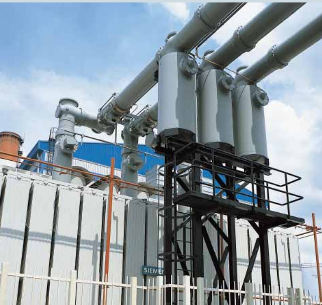
Элегазовые ОПН, подключенные к шине 420 кВ с элегазовой изоляцией
