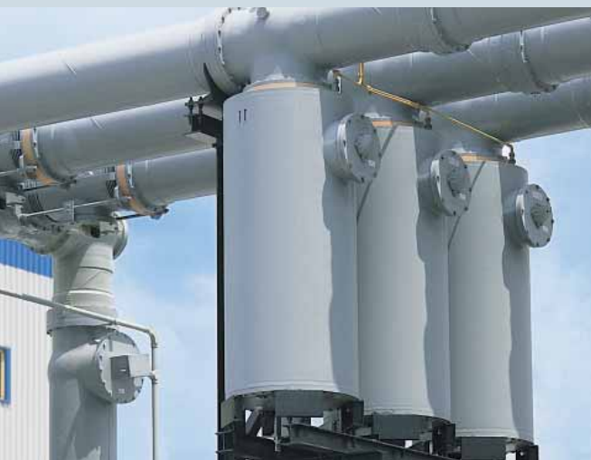
Элегазовые ОПН, подключенные к шине 420 кВ с элегазовой изоляцией
